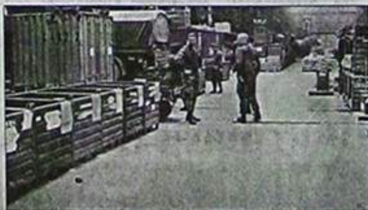
Ein Blick in die Kesselschmiede der Delmenhorster Soldaten.
